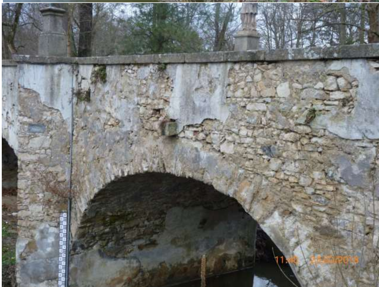
Pohled na levou stranu mostu (směrem od kláštera), viditelné masivní poškození a nesourodost omítky, dochází k obnažení kamenného zdiva, patrné vydrolené spáry ve zdivu mostu, které umožňují usazování náletových dřevin
