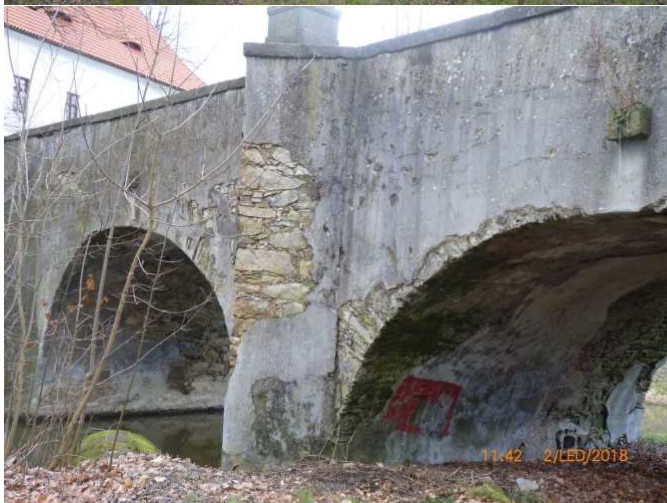
Pohled na pravou stranu mostu (směrem od kláštera) a mostní oblouky, i zde viditelné poškození omítky
