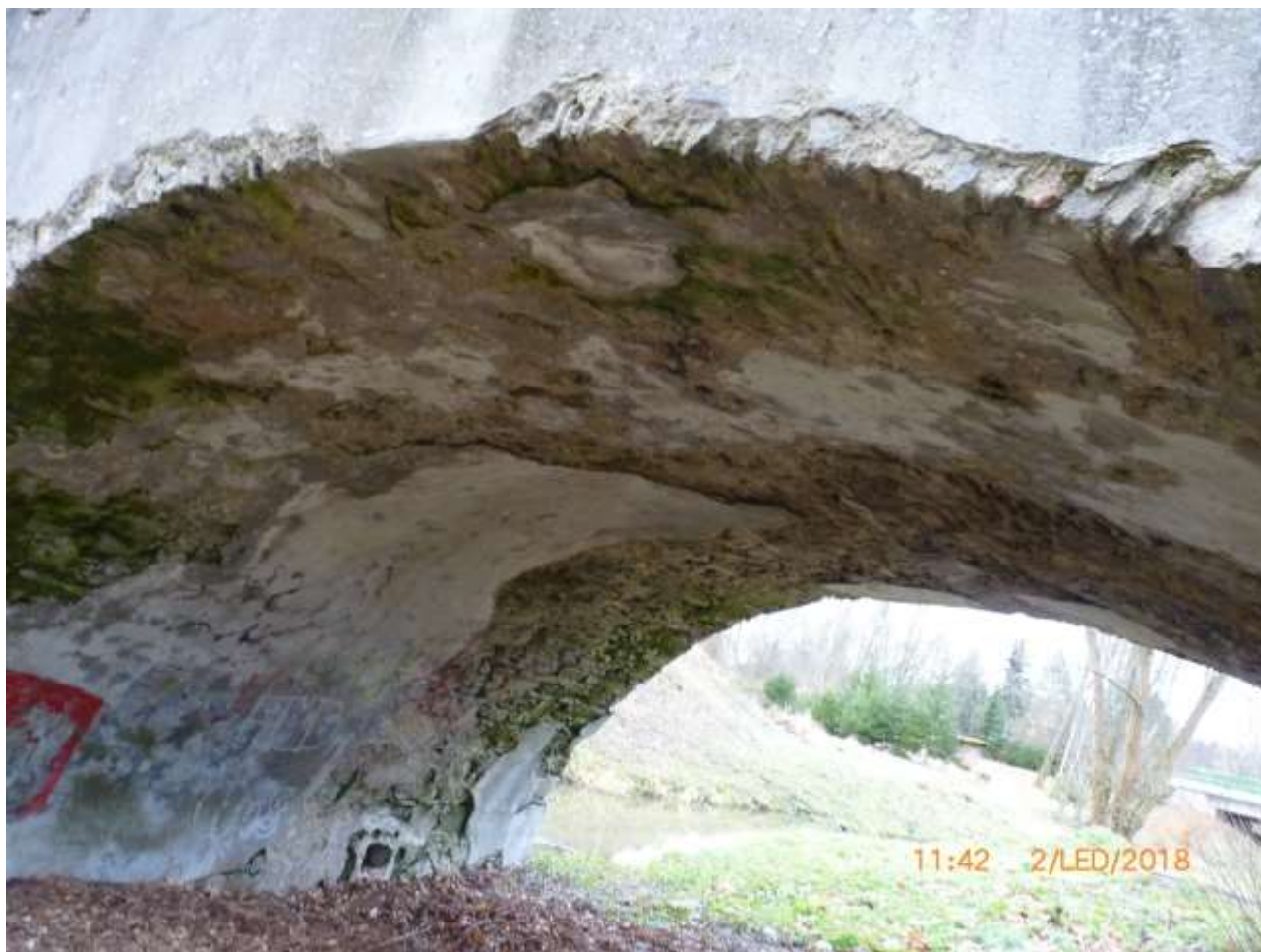
Bližší pohled pod mostní oblouk, kde je opět masivně porušená omítka, místy omítková vrstva zcela chybí
