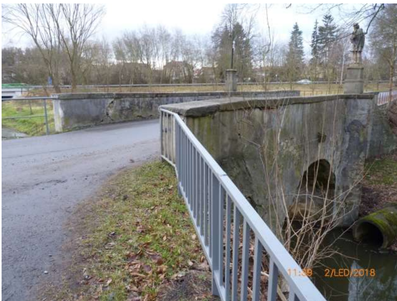
Pohled na most směrem od kláštera, znatelné porušení omítky, tmel mezi kamennými deskami ukončující zídky mostu je porušený, místy zcela vydrolený
