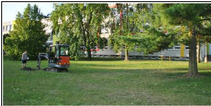
Obr.č. 1: Pohled do prostoru projektem předpokládaného umístění vsakovací komory s hloubenou sondou K1.
