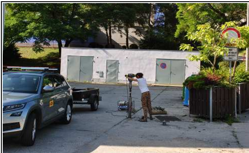
Obr.č. 9: V prostoru betonované manipulační zásobovací plochy základní školy vyhloubena sonda S4 .
