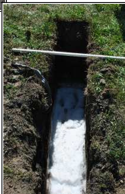
Obr.č. 5: V prostoru projektované komunikace vyhloubena sonda S2 k ověření úložných poměrů.
