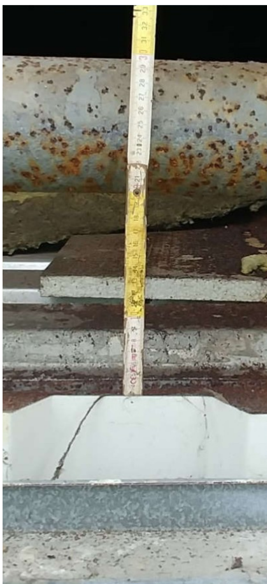
Detaily spodní a horní příče krajního ocelového rámu haly a spodní pásnice krokvičky s rozsáhlejší korozí krokvičky zřejmě v důsledku její méně kvalitní antikorozní ochrany oproti hlavním nosným prvkům rámu
