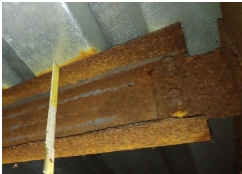
Detail styku krokviček s horní příčlí krajního rámu pomocí navařeného stykovacího plechu a dvojice šroubů - patrná rozsáhlá korozí na všech prvcích
