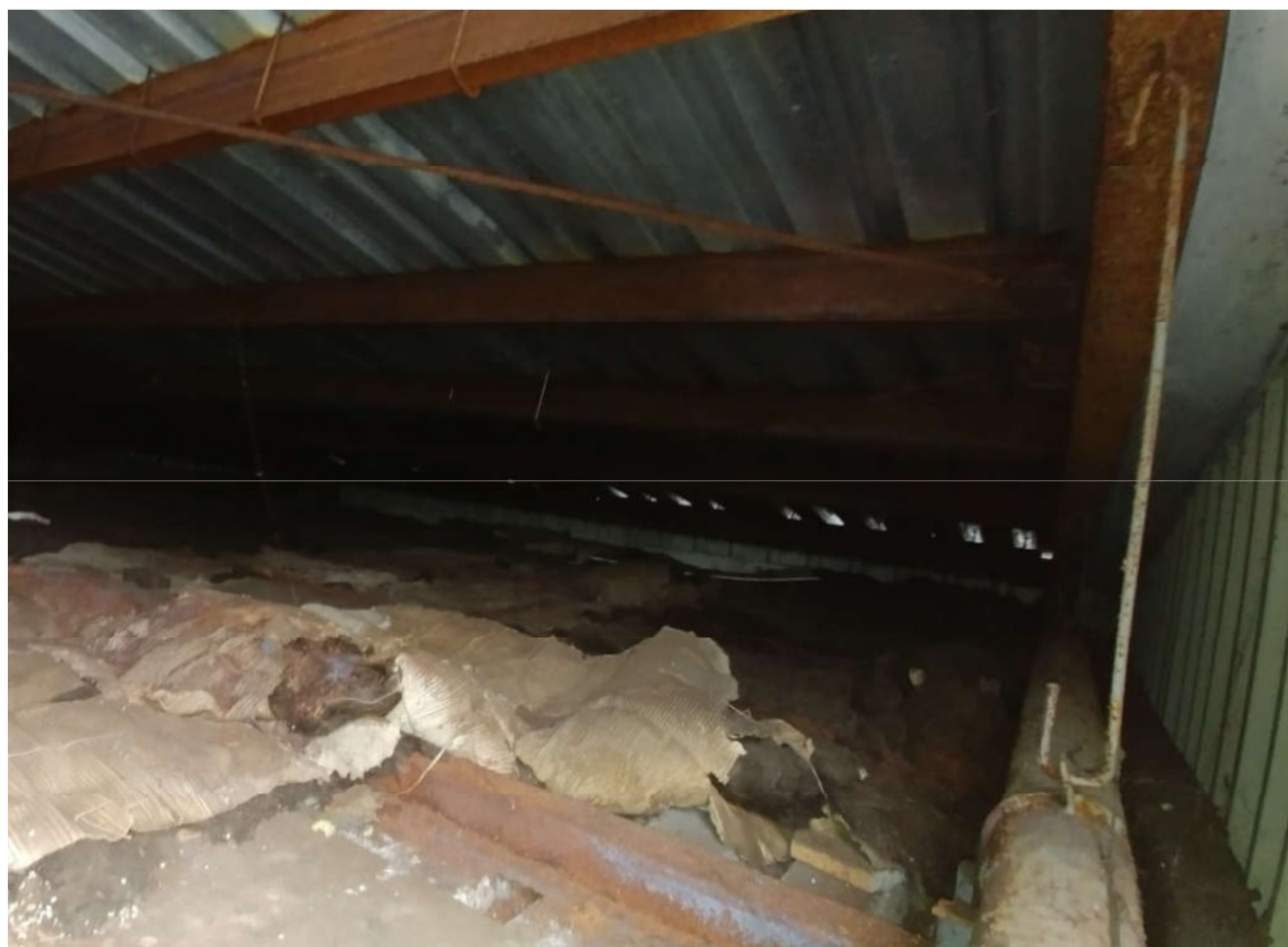
Celkový pohled do mezistřešního prostoru k okapu s patrným mezilehlým táhlem mezi horní a dolní příčlí rámu a tyčovým zavětrováním v rovině střechy pod spodními pásnicemi krokviček. V místě přeložené tepelné izolace je patrný nosník podhledu z ocelového válcovaného profilu, k němuž je zespodu přimontován trapézový plech tvořící vlastní podhled. Trapézový plech střechy je kotven pomocí táhel ke krokvičkám proti působení sání větru
