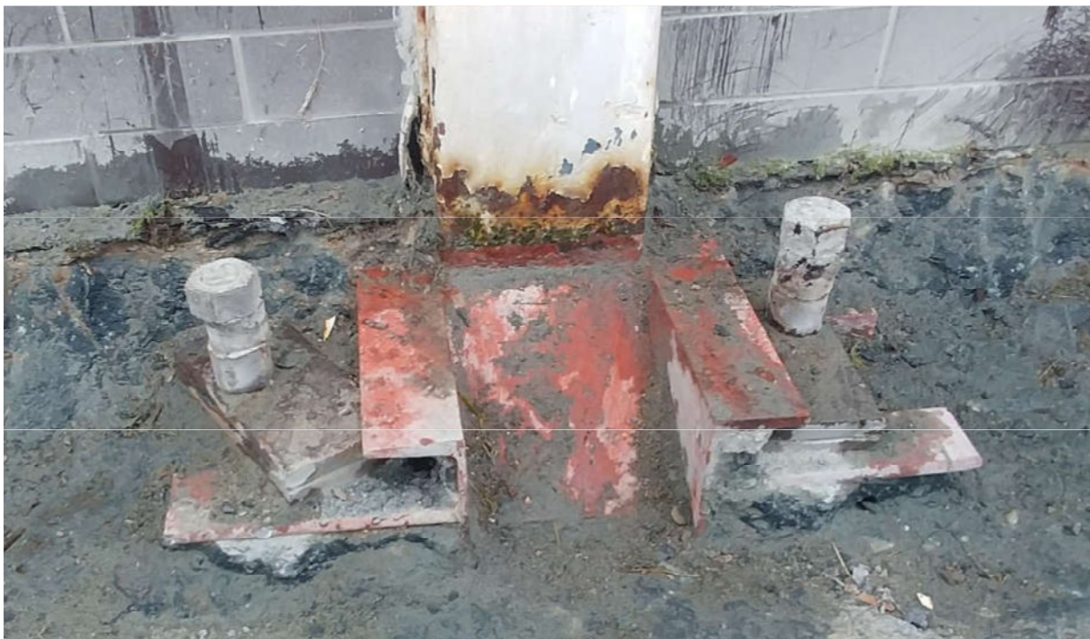
Pohled na venkovní část kotvení vnitřního nosného sloupu haly šířky 160 mm tvořeného roštem z válcovaných profilů U140 a plechů výztuh. Osy šroubů jsou situovány 100 mm před vnějším lícem ocelových sloupů haly s osovou roztečí 400 mm ve směru podélném haly
