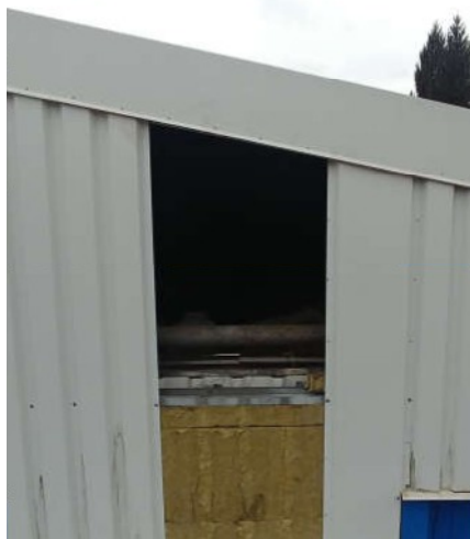
Pohled na místo demontáže štítové stěny pro umožnění přístupu do prostoru nad podhledem
