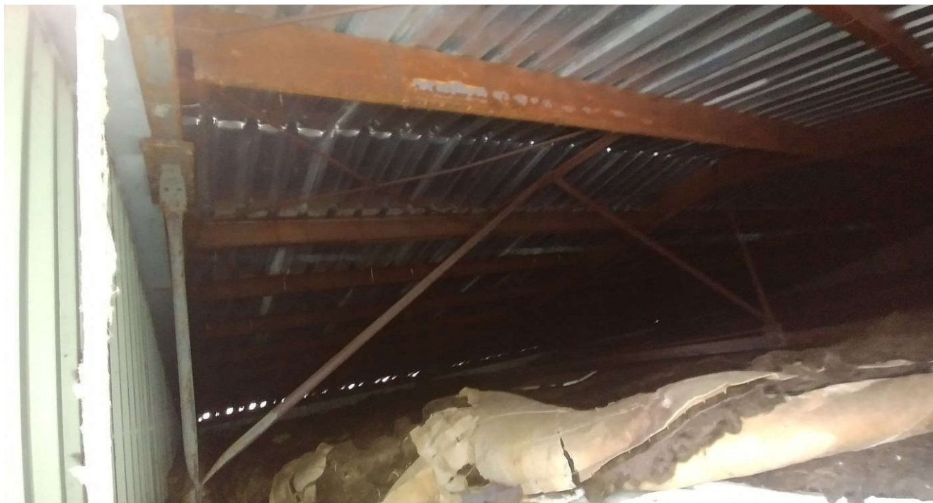
Celkový pohled do prostoru nad podhledem k vrcholu střechy s patrným středním robustním táhlem mezi horní a dolní příčlí rámu, jednoduchým svislým zavětrováním pod vrcholem střechy a s atypickým překonzolováním trapézových plechů za poslední krokvičkou směrem k vrcholu střechy z obou stran
