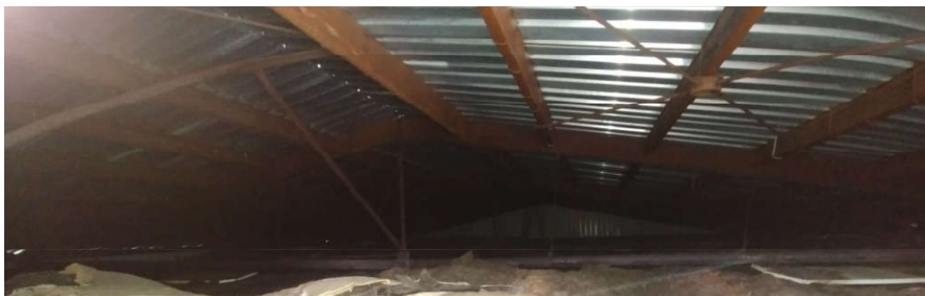
Celkový pohled do prostoru nad podhledem směrem k protilehlé štítové stěně s patrným tyčovým zavětrováním v rovině střechy pod spodními pásnicemi krokviček z U-profilů
